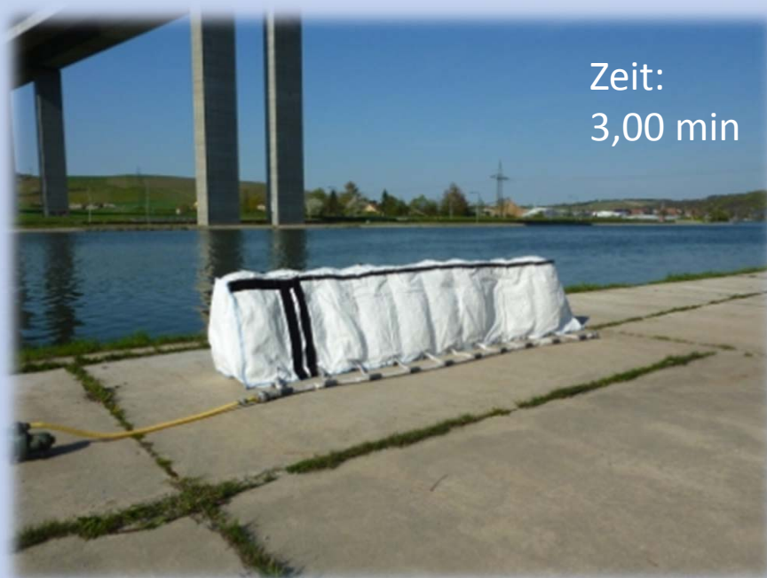
HWS-System mit Luft füllen
