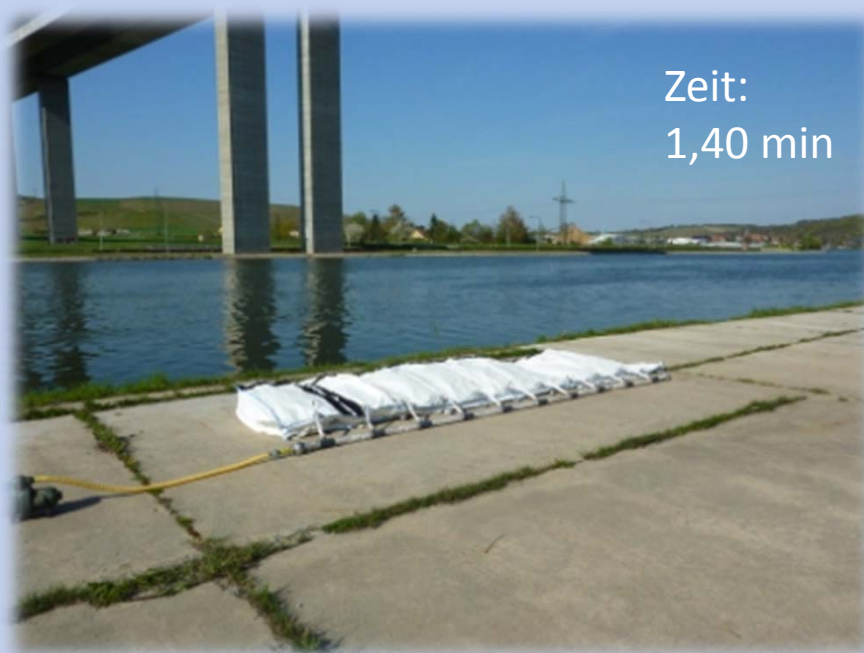
HWS-System mit Luft füllen
